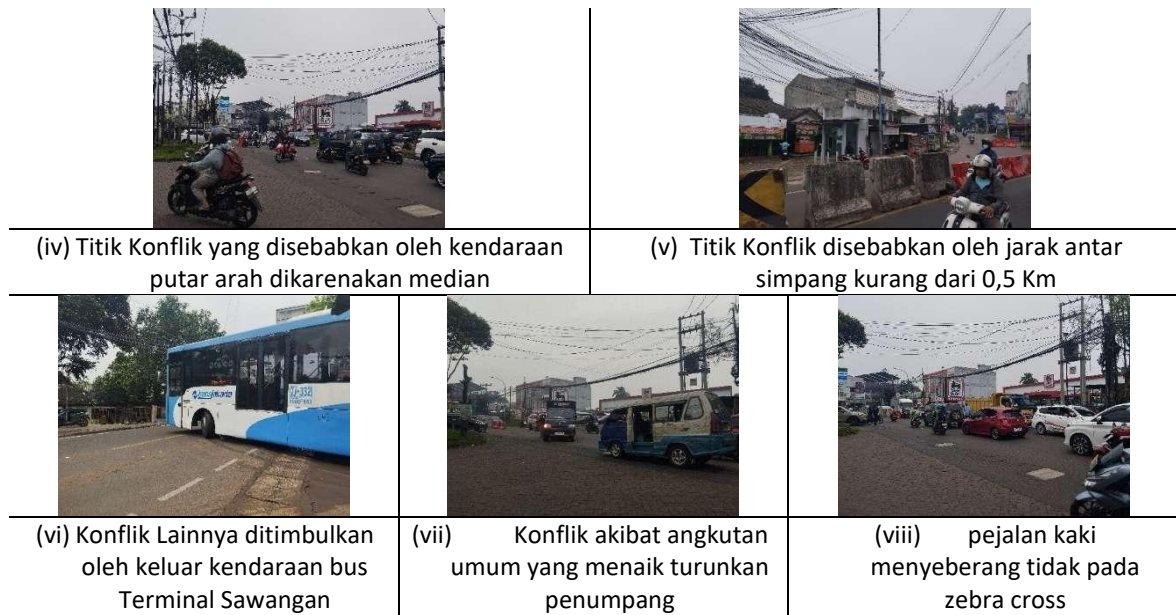
Gambar 4. Kondisi Persimpangan Jalan
