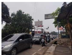
(i) Tidak adanya trotoar pada Jalan Muchtar Raya dan pada Jalan Sawangan Permai
